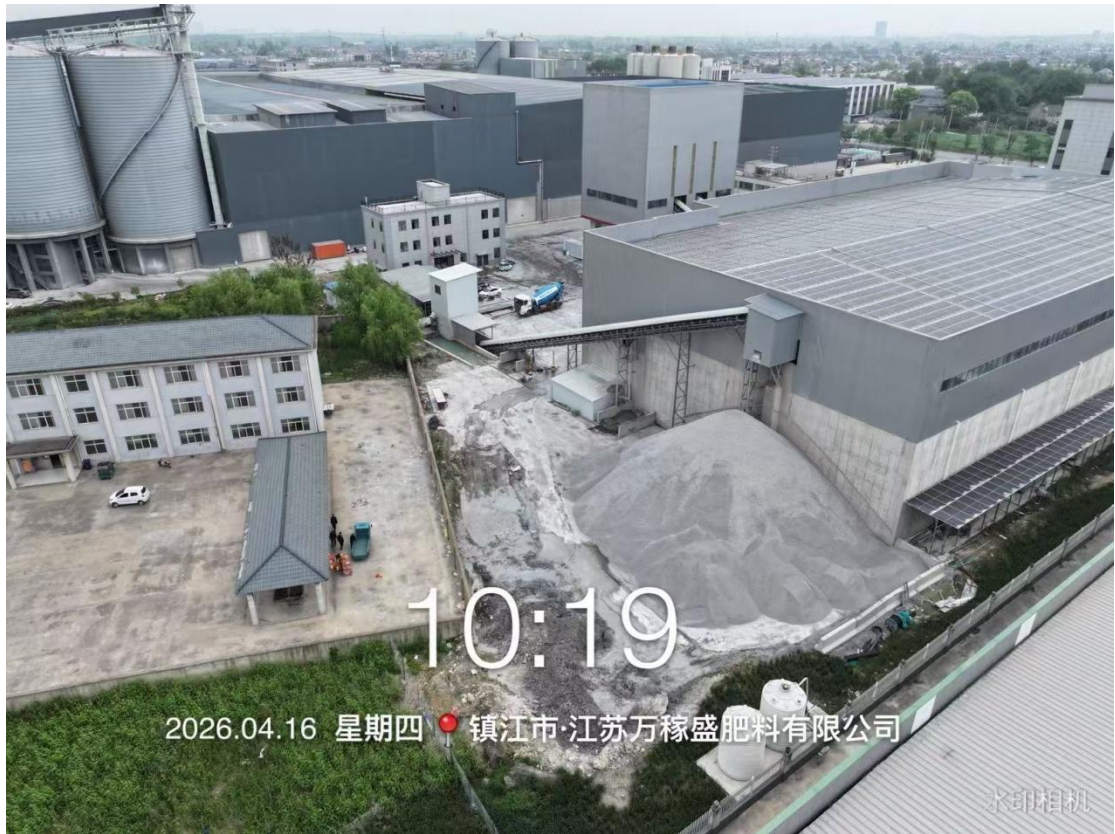
江苏万稼盛废料有限公司堆场
