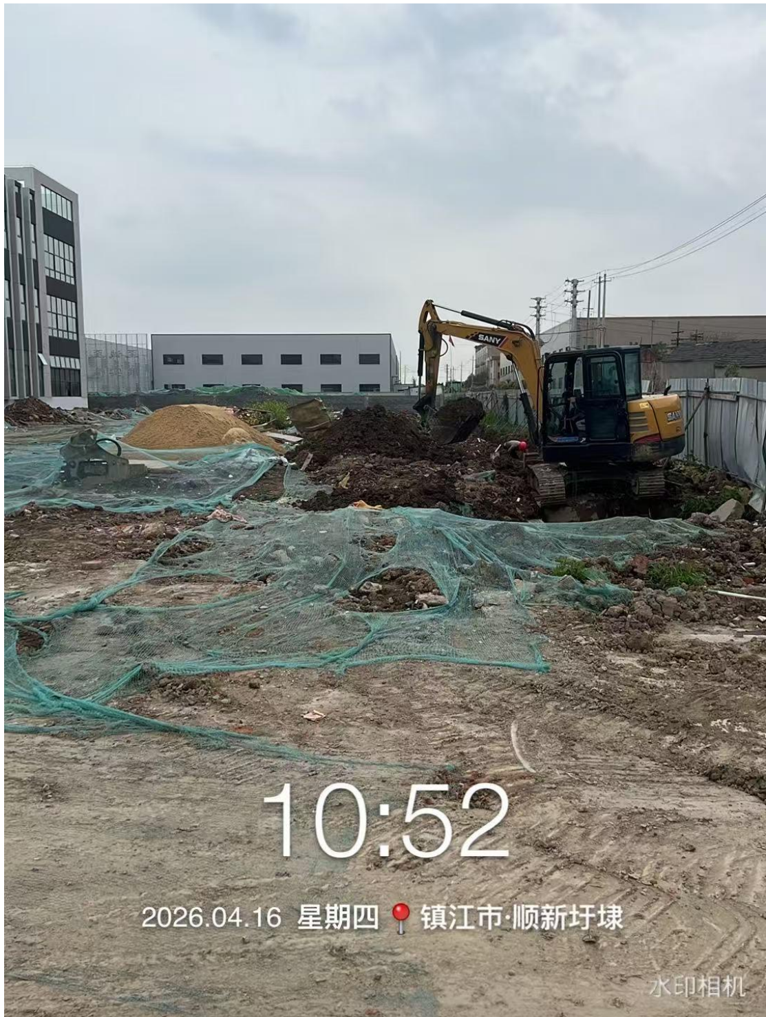
扬中市前进建材有限公司附近在建工地
