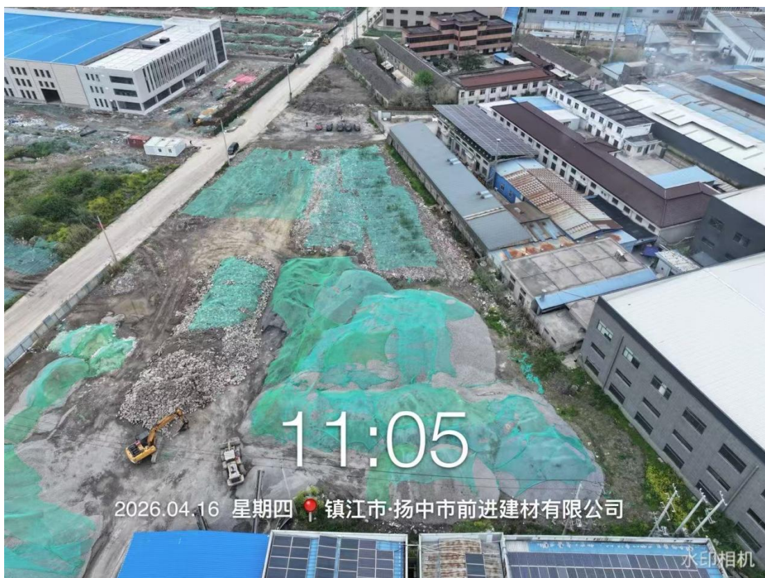
扬中市前进建材有限公司堆场
