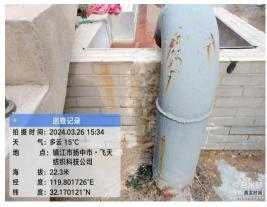
整改完成情况: 已要求厂方将污水引流槽裂痕修补,污水渗漏已完成整改。同时要求其加强自查自纠,避免类似问题再次出现。
