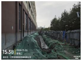
现场情况:施工现场砂石料与裸土已覆盖,无现场搅拌现象,出入口道路已清洗,现场要求加强管理,做好扬尘管控。
