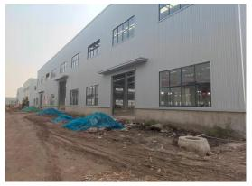
现场情况:施工现场已安排洒水冲洗积尘,部分建筑材料与裸土已覆盖,即将进行内部道路硬化,现场要求加强扬尘管控,及时洒水降尘并加强覆盖。
