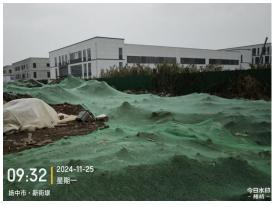
现场情况:该现场为绿色环保过滤设备项目,目前已完成大部分道路硬化,裸土已用绿网覆盖,现场要求加强道路洒水冲洗,做好裸土覆盖。
