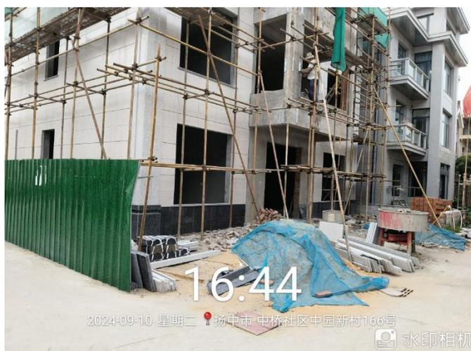
**现场情况：**现场已设置围挡，场内建筑材料已覆盖到位，路面已及时清扫。
