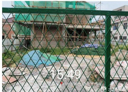
现场情况：现场已设置围挡，场地内建筑物料已覆盖到位。
