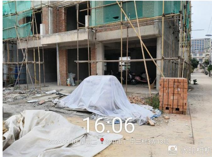
现场情况：场地内建筑材料已覆盖，现场要求及时对地面进行洒水降尘。
