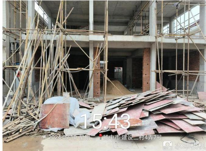
现场情况：现场正在进行脚手架的拆除，要求及时清运到位；地面已清扫，并洒水降尘。
