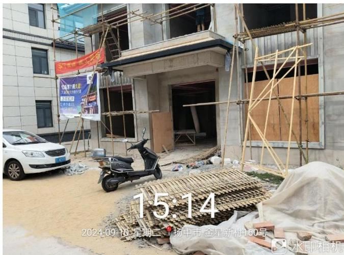
**现场情况：**场地内建筑材料已覆盖；地面积尘严重，未采取相关抑尘措施。
