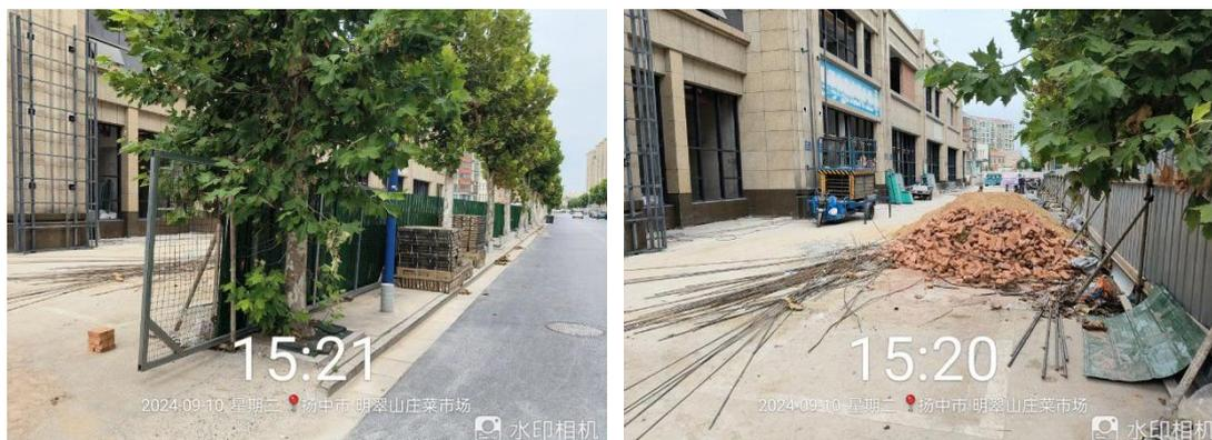
现场情况：现场已设置围挡；场内建筑材料未覆盖；地面积尘严重，未采取相关抑尘措施。
