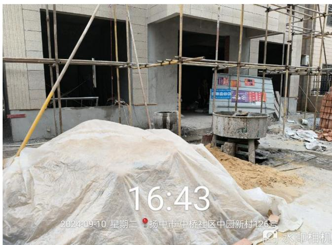
**现场情况：**场内建筑材料已覆盖到位，现场要求及时对地面进行洒水降尘。
