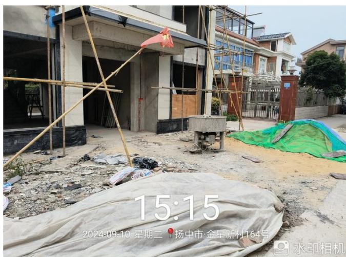
**现场情况：**部分建筑垃圾未覆盖到位；地面积尘严重，未采取相关抑尘措施。
