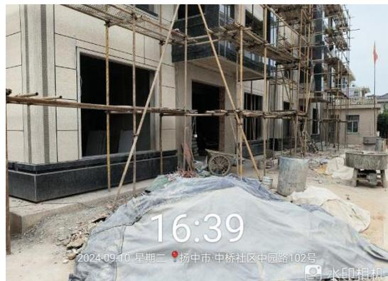
现场情况：现场已设置围挡；场内建筑材料已覆盖到位；现场要求及时对路面进行洒水降尘。
