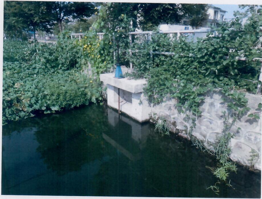
节制闸建设完成
