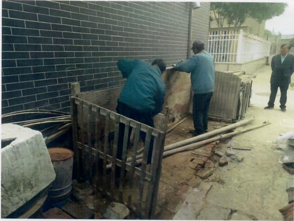
对鸡笼进行帮拆
