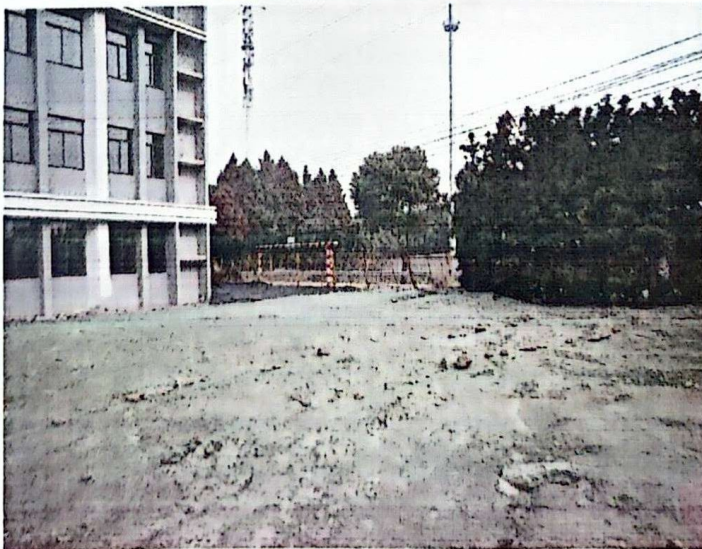
整改后：裸土覆盖
