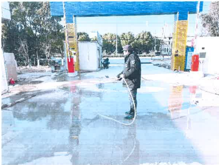
整改：对路面积尘洒水冲洗
