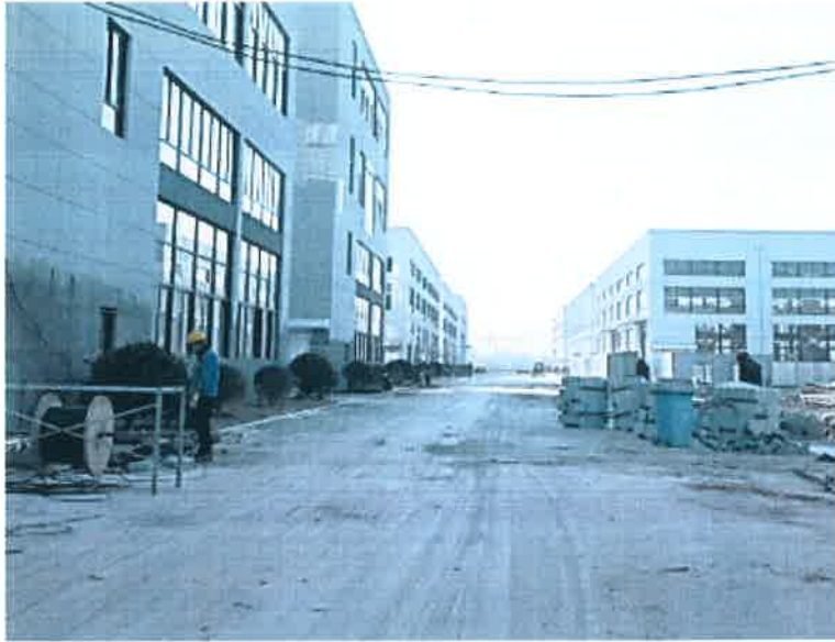
整改：已清运裸土，完成绿化施工
